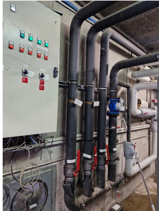
Les panoplies de distribution d'eau chaude sanitaire et d'eau froide, à reprendre dans le cadre du projet
