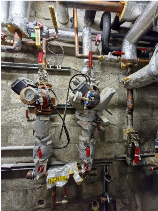
Les panoplies de distribution d'eau chaude sanitaire et d'eau froide, à reprendre dans le cadre du projet
