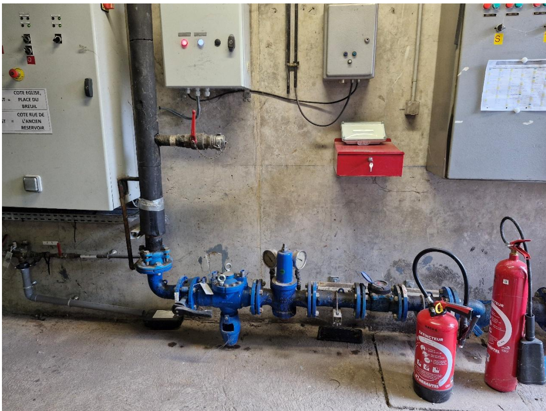
L'arrivée générale d'eau froide, à reprendre depuis la vanne en aval du disconnecteur, du compteur et du réducteur de pression
